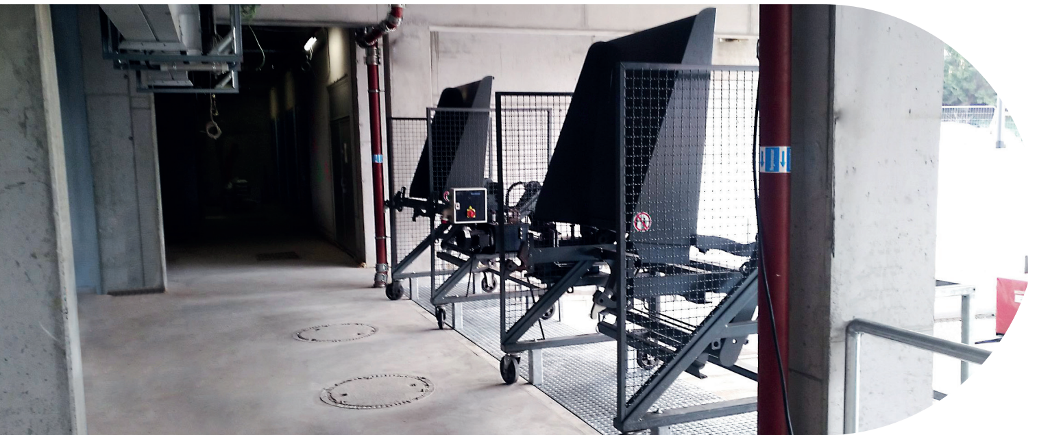
Rampenverlängerung für 2x PC 20 R und Hub-Kipp-Vorrichtungen
