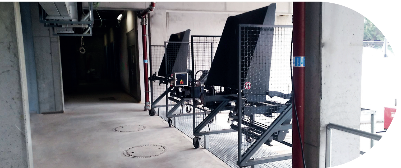
Rampenverlängerung für 2x PC 20 R und Hub-Kipp-Vorrichtungen
